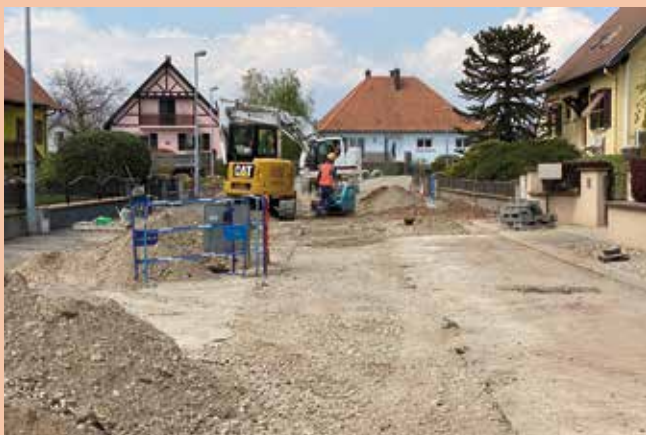
Les travaux entrepris par l'intercommunalité visent à améliorer le fonctionnement du réseau en cas de pluie.
