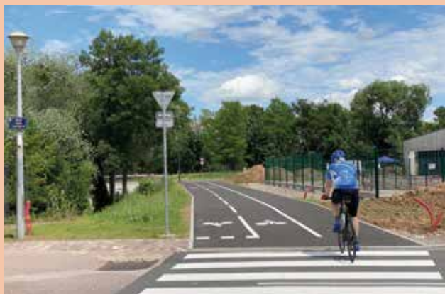
Le maillon de piste cyclable créé à proximité du nouveau bâtiment d'accueil du camping municipal permet de compléter le réseau existant.
