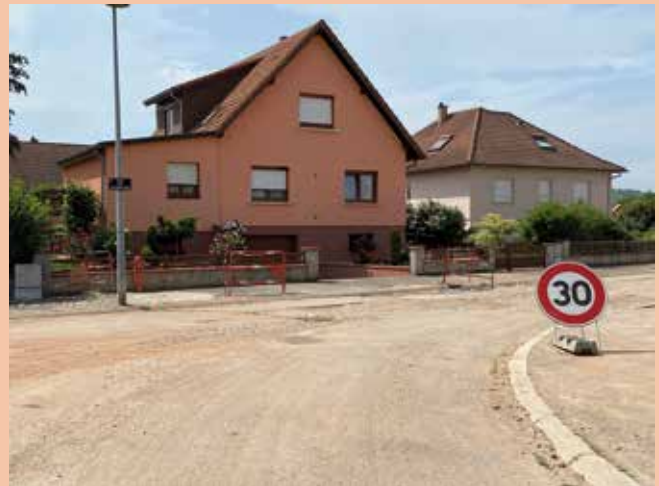
La vitesse de circulation a été limitée à 30 km/h dans l'attente des travaux de réfection des revêtements des voiries impactées.
