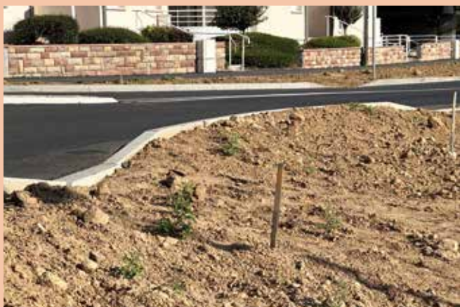
Les bordures de trottoir ont été abaissées pour restituer les eaux pluviales à la terre et à la nappe.
