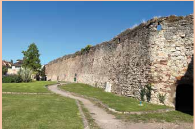
Le lierre avait tout d'abord été coupé afin que les tiges qui envahissaient le mur et ses interstices se dessèchent. Il a ensuite été enlevé au courant de cet été.
