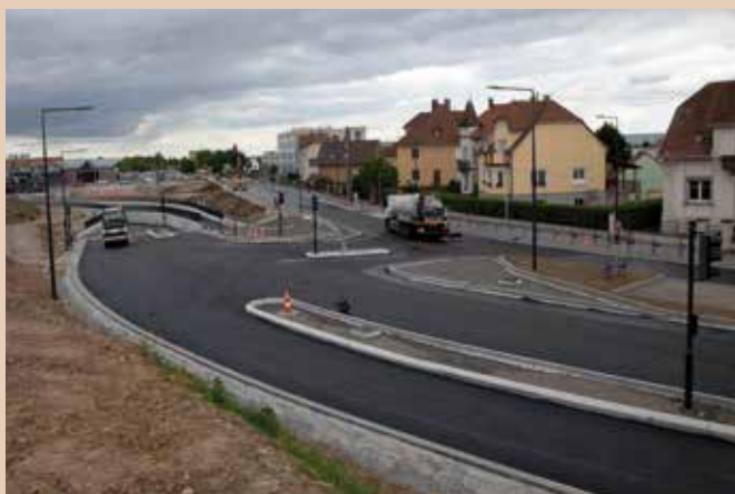
Les premières couches d'enrobés de la rue de la Commanderie ont été tirées fin mai. Terre-pleins et autres aménagements ont également été réalisés. Par ailleurs, en accord avec les préoccupations écologiques et économiques, de nouveaux mâts lumineux à Led ont été installés de part et d'autre de la voirie.
