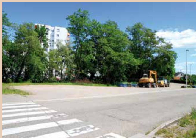
La création d'un parking avec 41 aires de stationnement est prévue à l'angle de la rue de la Fonderie et de la rue Ernest Friederich.
