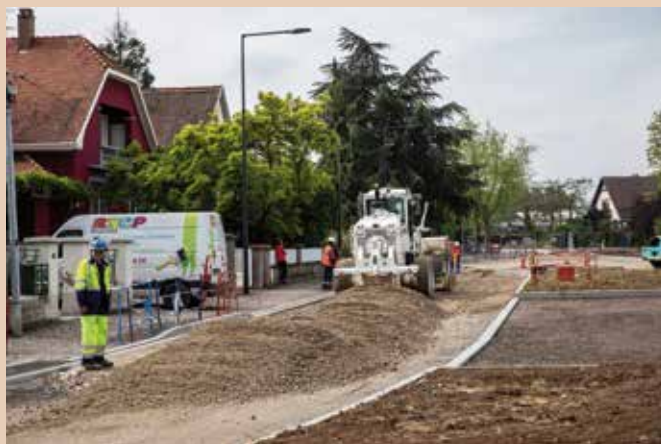
Avant de poser les enrobés, les ouvriers de l'entreprise Eurovia ont procédé aux différents terrassements et nivellements de la voirie.
