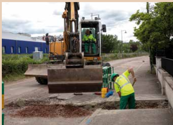
Les ouvriers terminent les branchements des particuliers au réseau d'eau potable.
