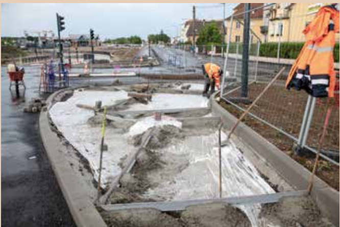
Les îlots directionnels et les terre-pleins ont été bétonnés début juin. Ce matériau atteint sa résistance maximale au bout de 28 jours.
