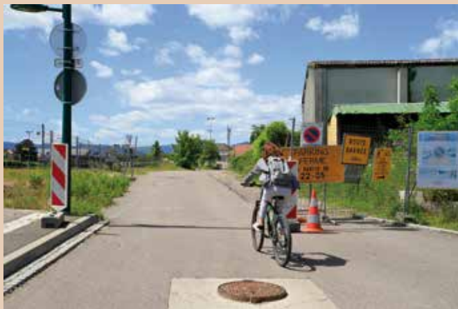
L'accès au parking de la gare côté centre-ville a été interdit aux voitures (sauf pour les riverains) afin de réaliser l'aménagement de la piste cyclable.
