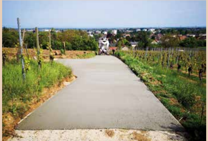
Le bétonnage a été réalisé courant du mois de mai en calculant une pente suffisante pour permettre un écoulement optimal.
