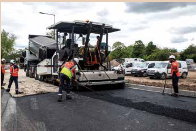
Les premières couches d'enrobés de la rue de la Commanderie ont été tirées fin mai. Terre-pleins et autres aménagements ont également été réalisés. Par ailleurs, en accord avec les préoccupations écologiques et économiques, de nouveaux mâts lumineux à Led ont été installés de part et d'autre de la voirie.
