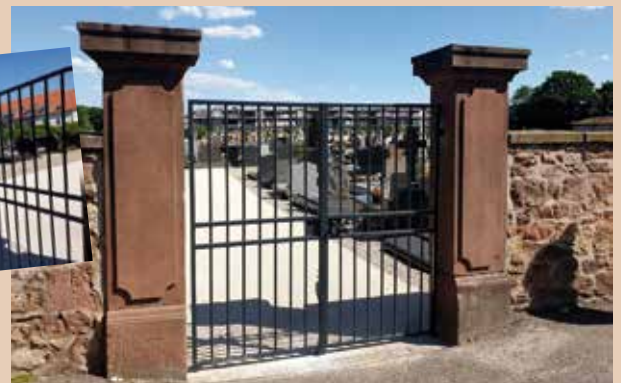
Un thermolaquage des grilles a été effectué pour limiter les agressions des éléments extérieurs comme le soleil ou l'humidité.
