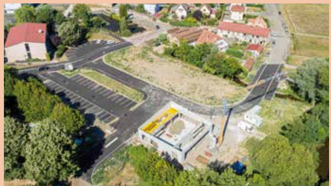
Cette vue permet d'apprécier l'avancement du chantier. La partie voirie est terminée et la construction du bâtiment d'accueil du camping se poursuit (photo Drone Sessions).
