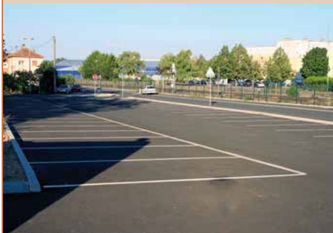
Situé à l'angle de la rue de la Fonderie et de la rue Ernest Friederich, le parking comprend 41 aires de stationnement dont une destinée aux personnes à mobilité réduite.
