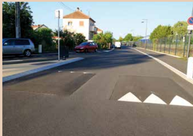
Outre les doubles places de stationnement matérialisées au sol côté habitation, des coussins berlinois ont été implantés pour jouer le rôle de brise-vitesse.
