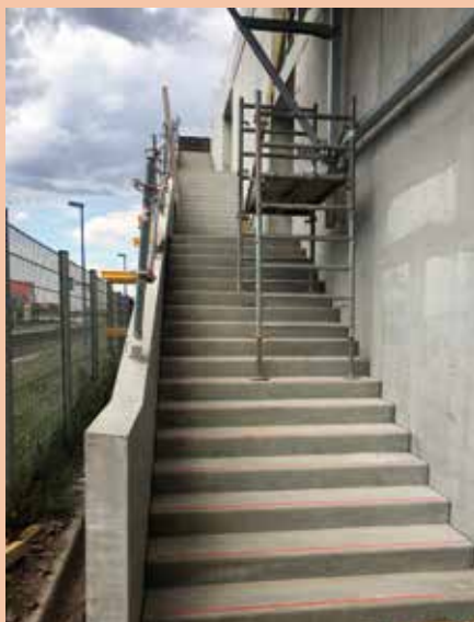
Un escalier permet d'accéder directement à la voie.
